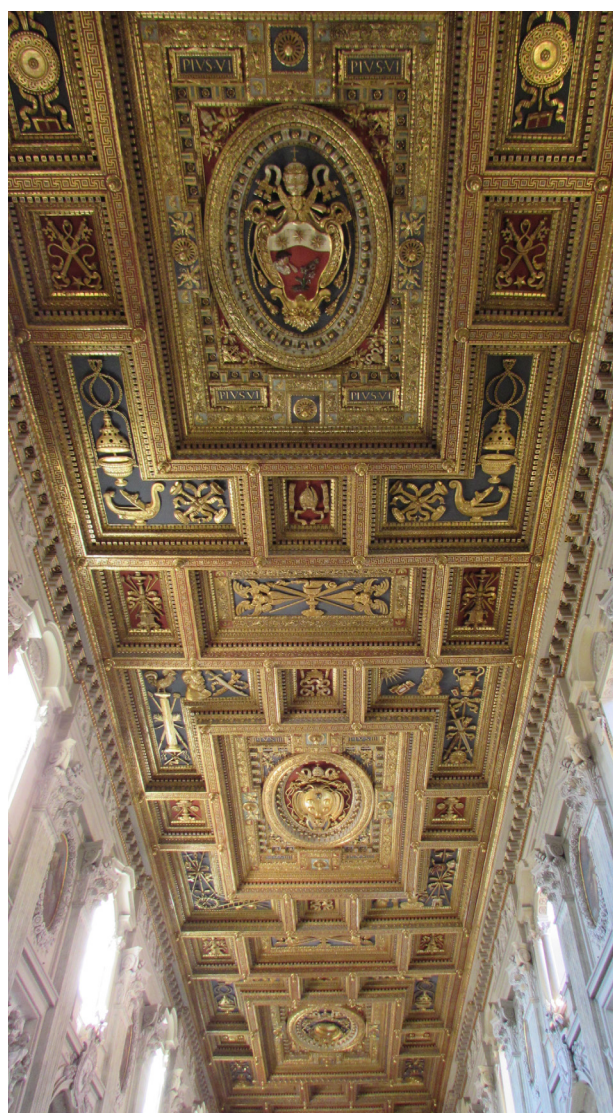
Plafond à caissons de la basilique
